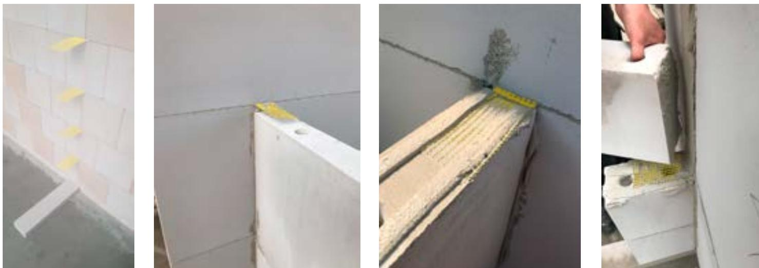
Die Bildreihe zeigt das Konstruktionsprinzip und die Verarbeitung der **BMO FlexVerbinder**.
