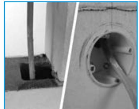
Die Steinöffnungen können hervorragend als Kabelleitungen genutzt werden. Die Größe der Öffnungen sichert dabei immer einen Durchstoß der Kabel zu. Die Verwendung handelsüblicher Hohlwanddosen ist mühelos möglich. **Einfacher geht es nicht!**
