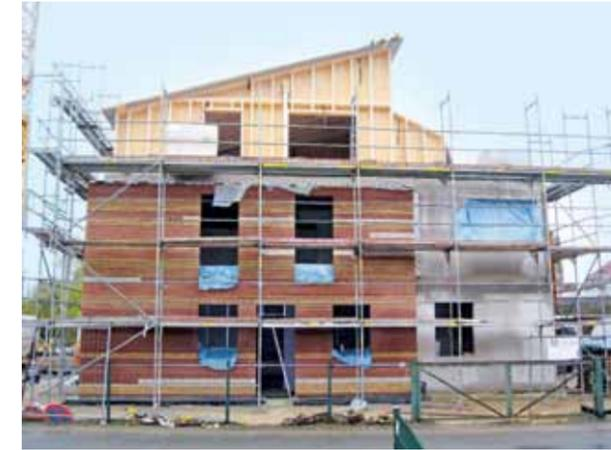
Erd- und Obergeschoss sind in Massivbauweise gebaut, während das Staffelgeschoss ganz oben als passivhaustauglicher Holzrahmenbau ausgeführt ist.
